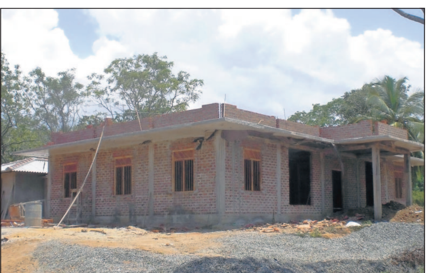
Bauphase: Das Eliya Kinderheim entsteht. Auf einem Stück Land in Sri Lanka realisiert Angelika Riedlinger ihren Traum, den Bau eines Kinderheims. Dazu hat sie einen Verein gegründet, der von Deutschland aus operiert und das Projekt unterstützt. Vor wenigen Tagen wurde das Kinderheim offiziell in Betrieb genommen. FOTO: PS
