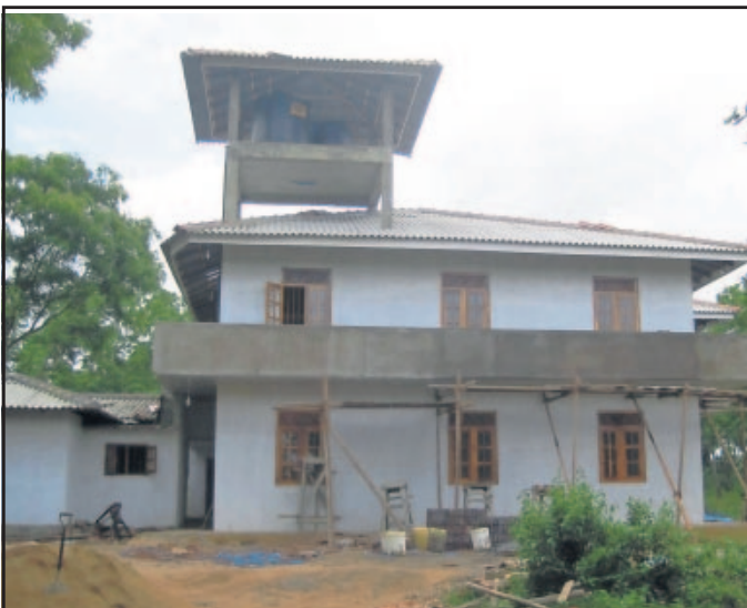
Finale Bauphase: das Kinderheim steht. FOTO: PS
