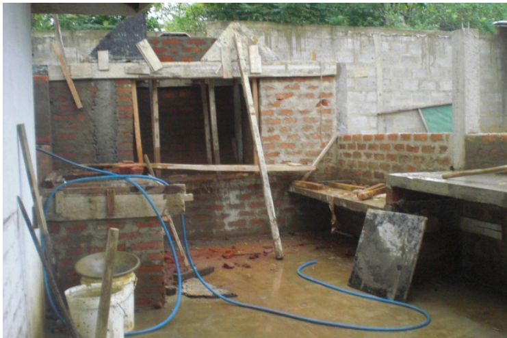
"Pfälzer Küche" im Bau!
