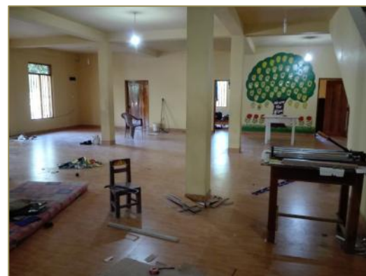
Eliya Kinderheim beim Fliesen verlegen
